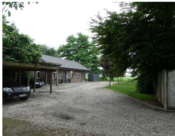
Foto 2: Blick von Norden auf das südöstliche Wohnhaus (Nr. 4)
